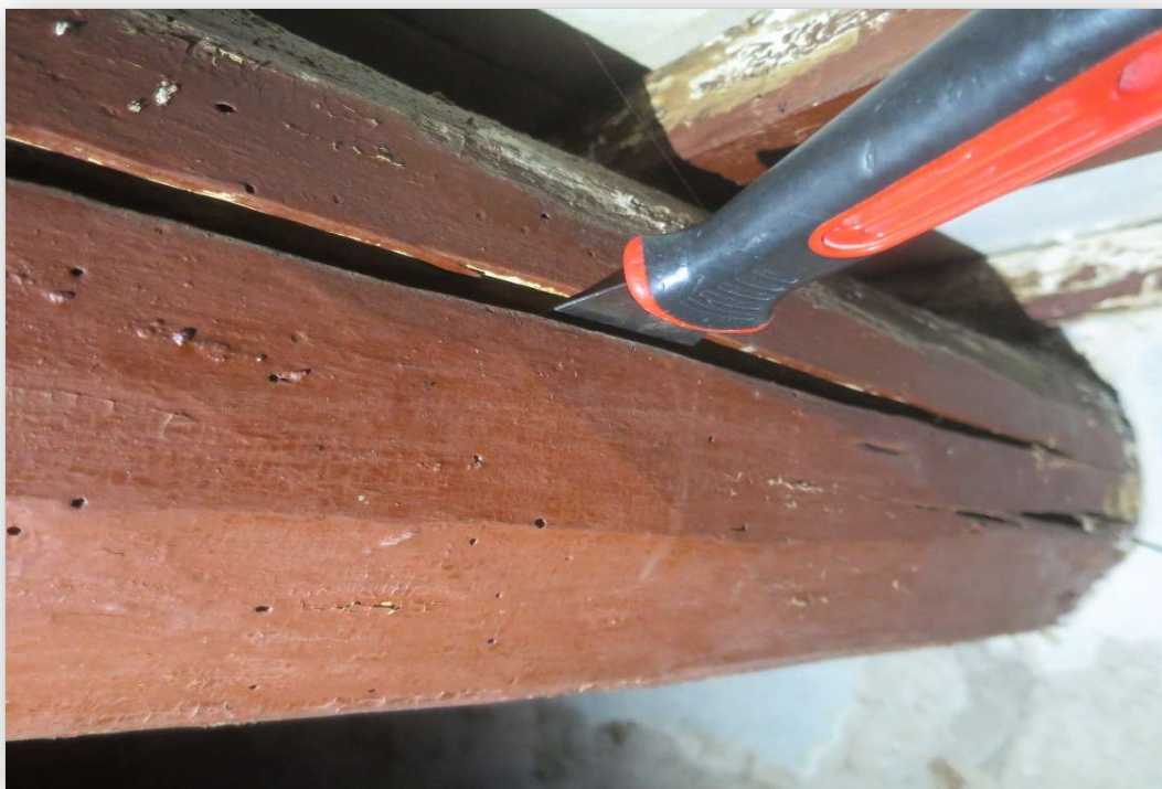
Sostre de la planta segona (P2), porta 1 (P1). Element P2P1A8. Imatge 042 Clivelles marcades horitzontals
