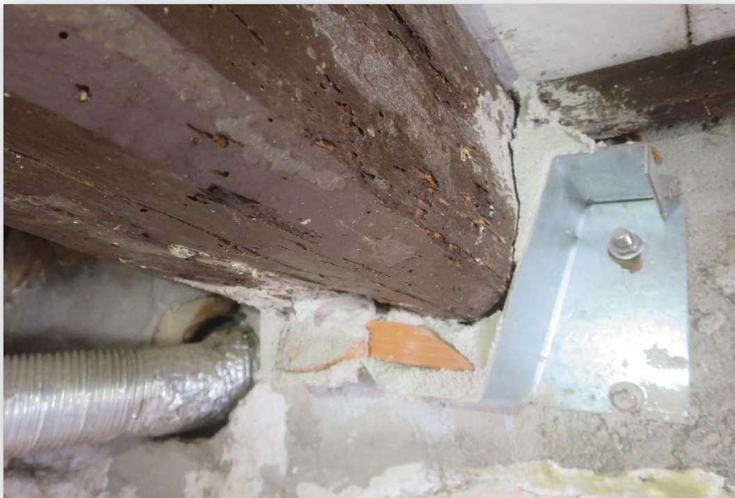
Sostre de la planta segona (P2), porta 1 (P1). Element P2P1A14. Imatge 046 Degradació causada per cors i fongs de podriment Element reforçat en l'extrem sud-oest, l= 10 cm
