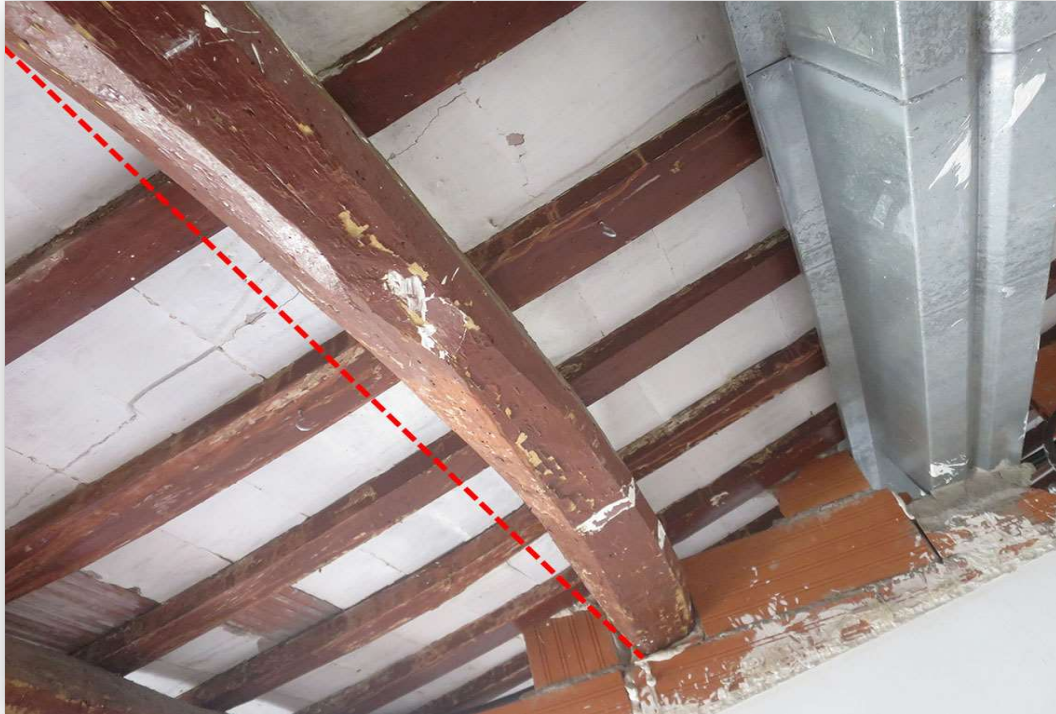
Sostre de la planta segona (P2), porta 2 (P2). Element P2P2A15. Imatge 052 Desviació de les fibres respecte a l'eix longitudinal
