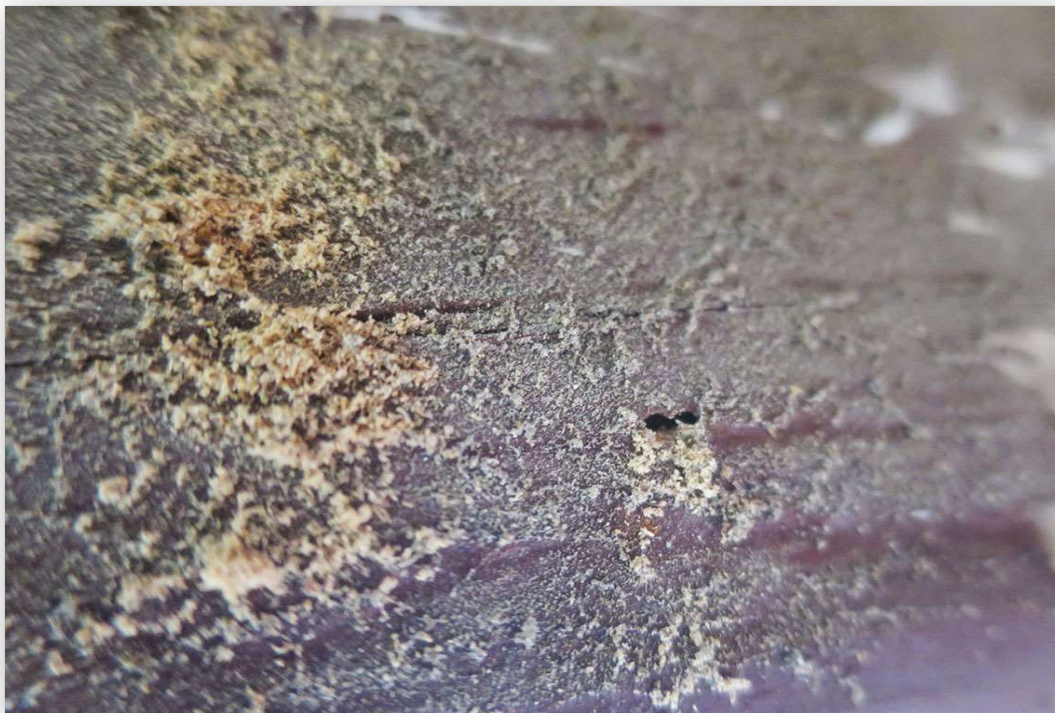
Sostre de la planta segona (P2), porta 2 (P2). Element P2P2A2. Imatge 056 Forats de sortida de corcs de petita grossària (família Anobiidae) Serradures produïdes per la sortida de corcs adults
