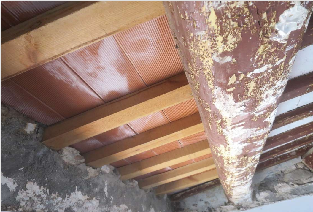
Sostre de la planta segona (P2), porta 2 (P2). Element P2P2A1. Imatge 054 Tauler i llatges renovats
