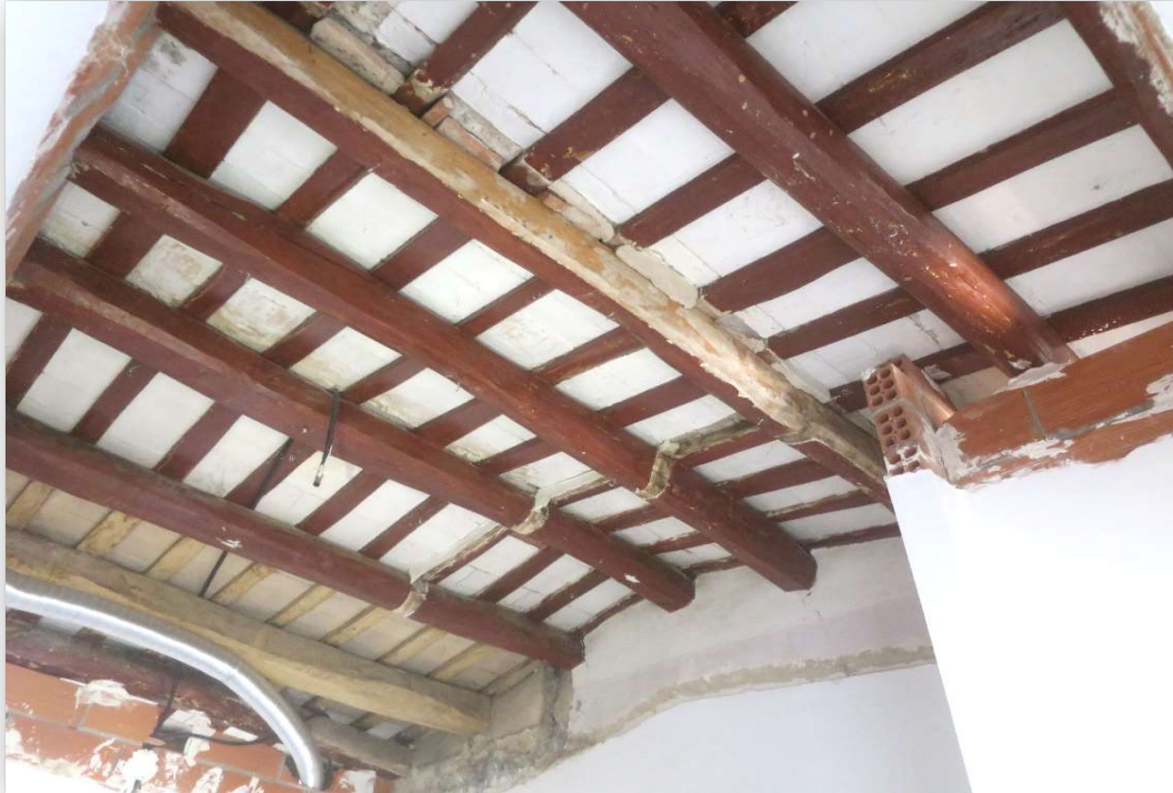
Sostre de la planta segona (P2), porta 2 (P2). Imatge 049 Vista general
