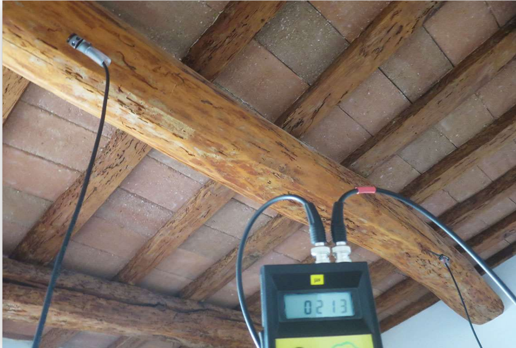
Sostre de la planta segona (P2), porta 1 (P1). Element P2P1A15. Imatge 035 Assaig amb ultrasons per estimar les propietats resistents de la fusta
