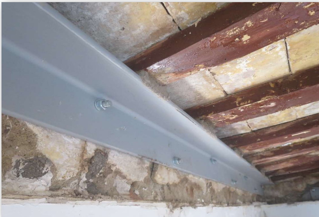
Sostre de la planta segona (P2), porta 1 (P1). Element P2P1A1. Imatge 040 Consolidació del recolzament de les llatres a la façana
