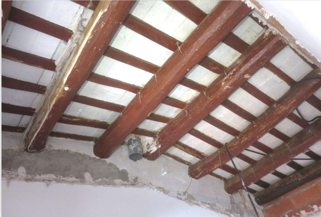
Sostre de la planta segona (P2), porta 1 (P1). Imatge 034 Vista general
