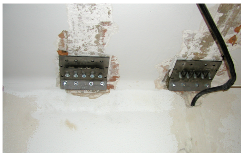
Anclaje de placas
