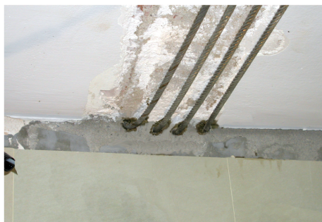
Anclaje de tendones
